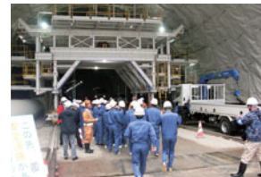
現場見学（全学年） （下屋形トンネル）
